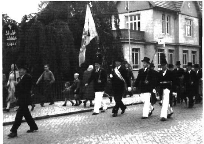
- 1953 - Ausmarsch, auf der Beeckerbrücke - dahinter die alte Kreissparkassen-Villa
