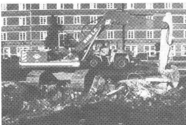
Davor lag eine fast 2jährige Bauzeit
